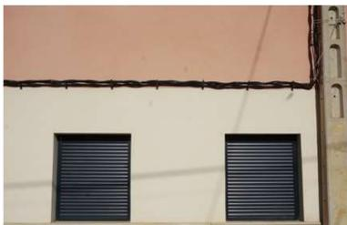
Aunque el cable tiene aislamiento, se trata de un cable en tensión. No lo manipule y AVISE a Edistribución si hay algún tipo de incidencia que le afecte.
