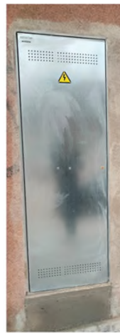
Vista exterior puerta
